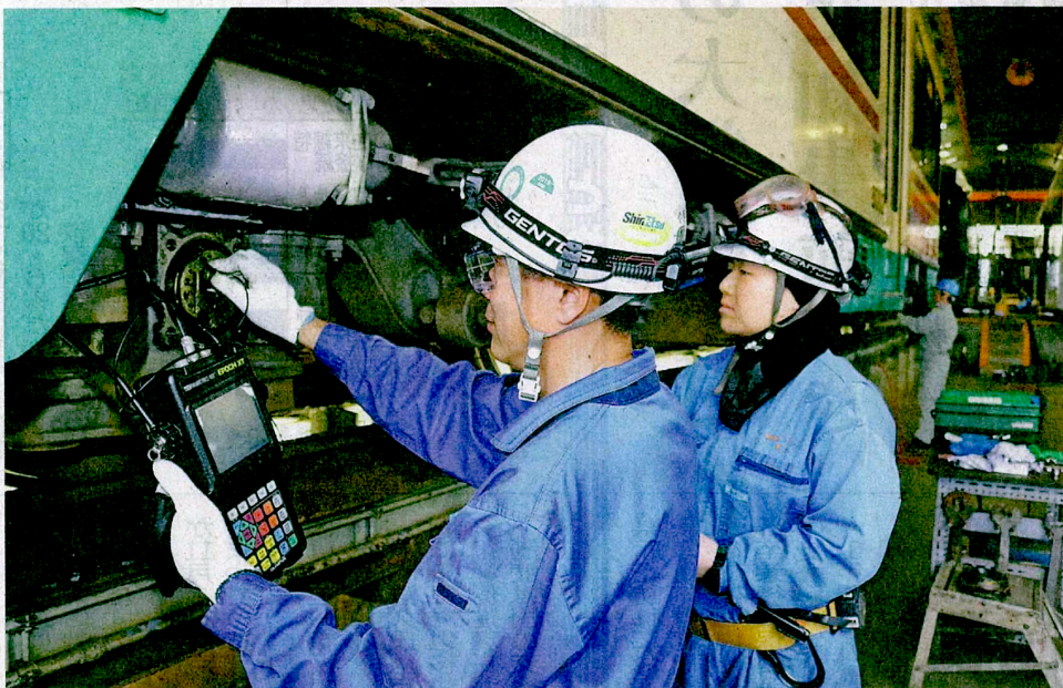
超音波探傷器で車軸を検査する山崎さん(左)と有山さん(右)南富山車両基地
