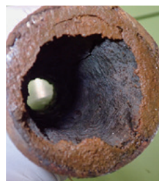
配管閉塞調査
