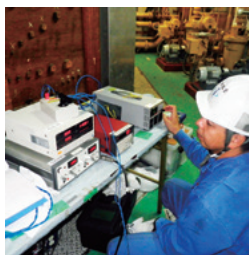
水力発電所の ガバナ試験
