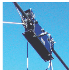
ワイヤーロープ 素線断線検査
