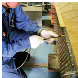
渦電流探傷による熱交換器チューブの試験
